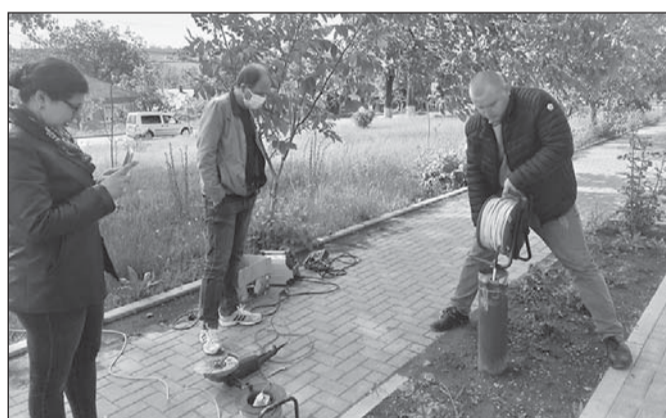
Senzorii urmează a fi instalați în raioanele: Ocnița (s. Calarașeuca și s. Ocnița); Dondușeni (s. Elizavetovca);
